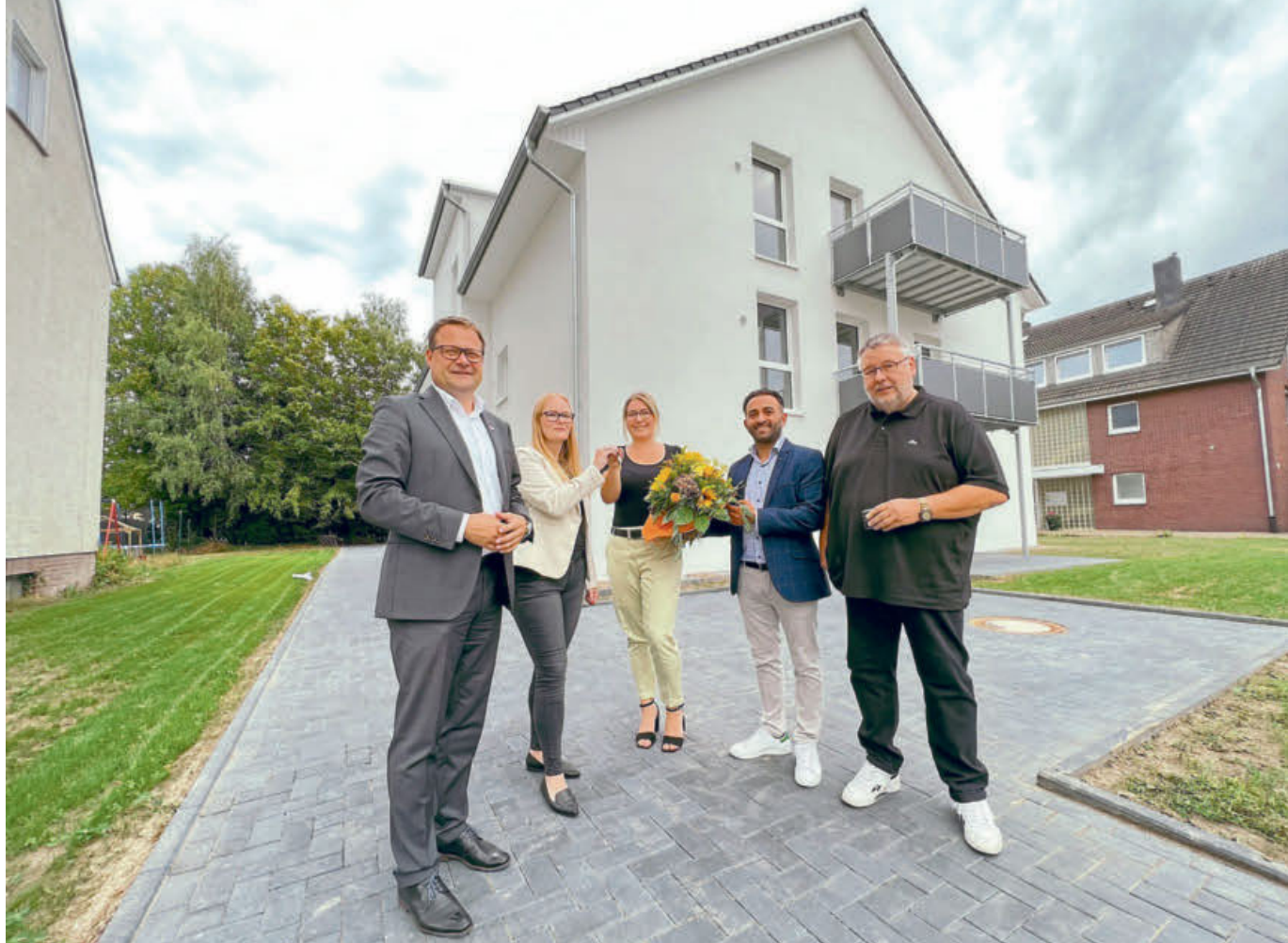
Bürgermeister Lars Bökenkröger (links), SGH-Aufsichtsratsvorsitzender Ralf Sensmeyer (rechts) und SGH-Geschäftsführer Dr. Alcaay Kamis (2. von rechts) freuen sich über die Fertigstellung der Immobilie an der Memeler Straße 12. Als eine der ersten wird dort Michelle Bullerjahn (3. von rechts) einziehen. Den Schlüssel erhält sie von Nadine Rehs (2 von links). Foto: Lydia Böhne
